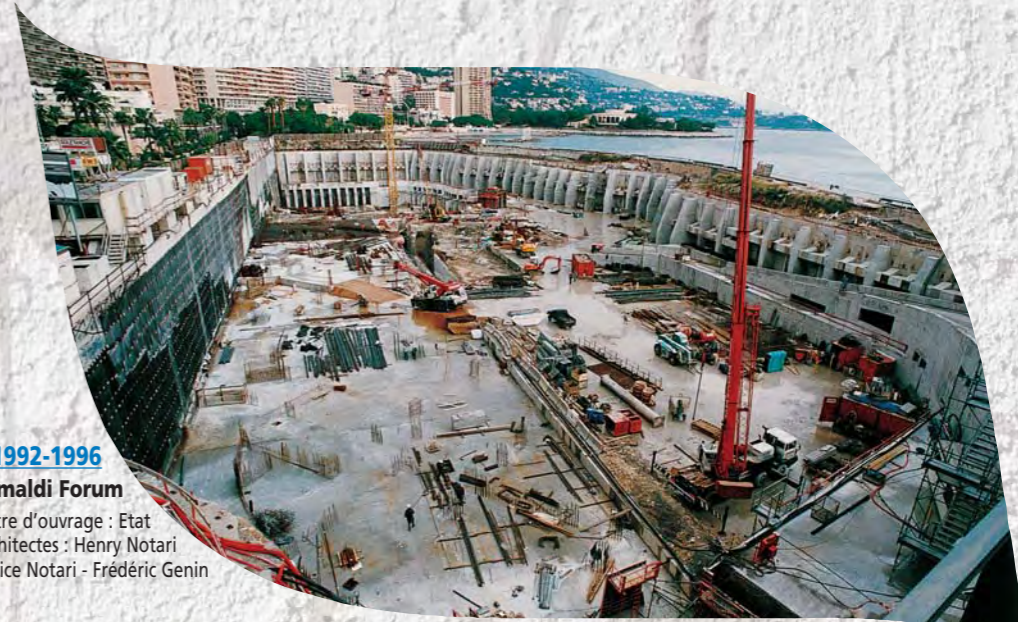
Encuvement (barrage) en mer autostable Conception et direction travaux pour Solétanche
