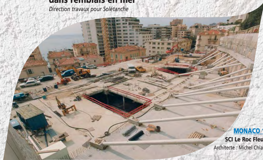
Procédé d'infrastructure "Up and down" Conception et direction travaux pour Solétanche
